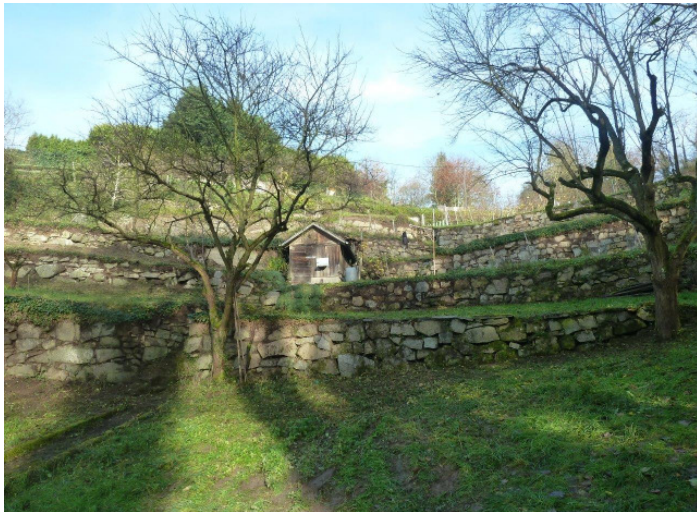
Das Ergebnis – freigestellte Trockenmauern
