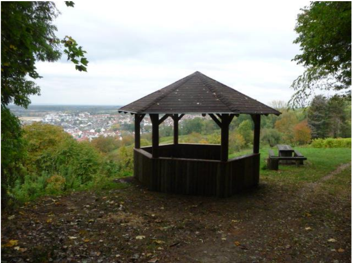
Der neue Pavillon mit Blick auf Laudenbach (Quelle: Gemeinde Laudenbach)
